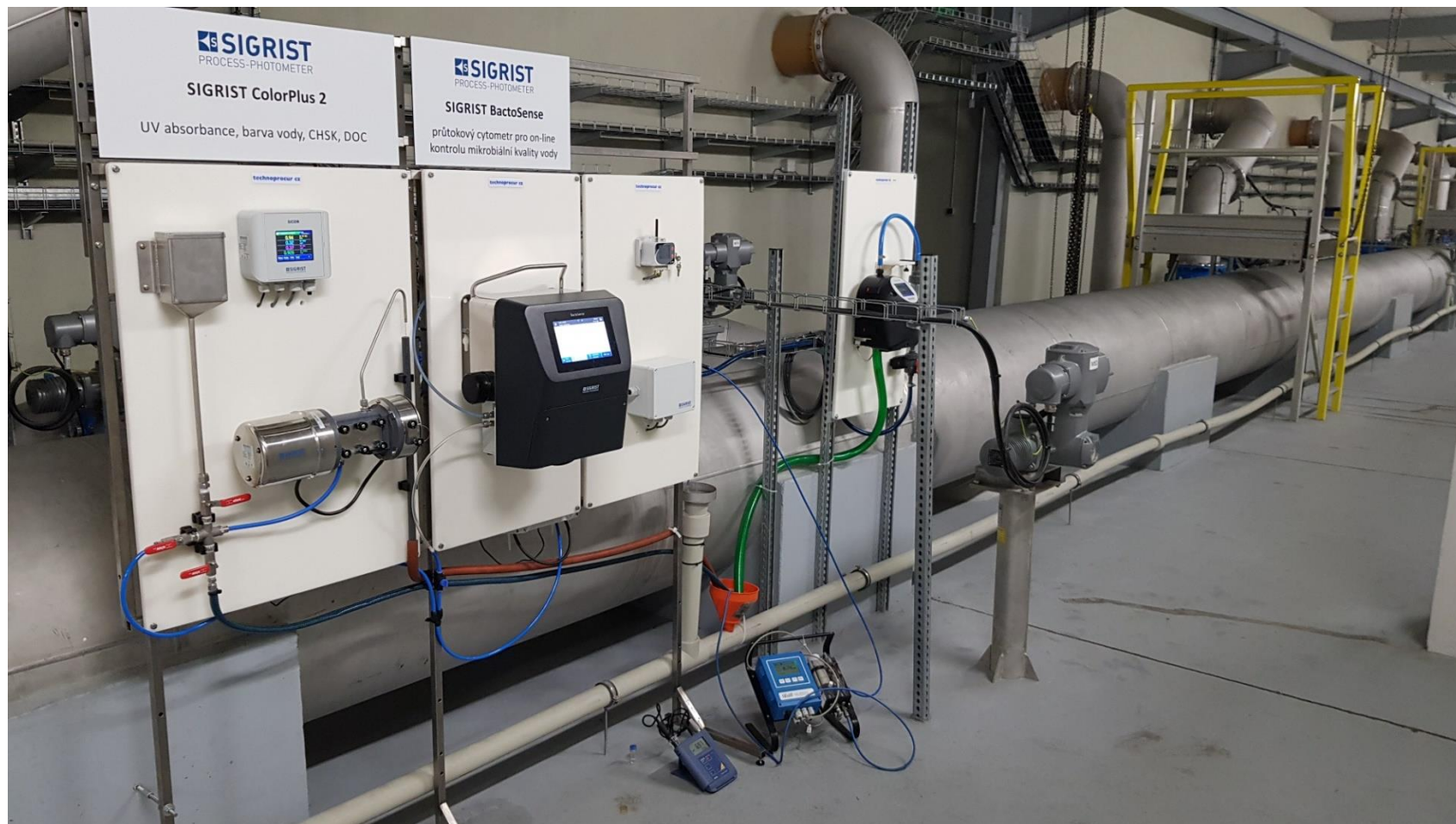
Výstup GAU filtru - sestava analyzátorů SIGRIST (ColorPlus, BactoSense, AquaScat)
